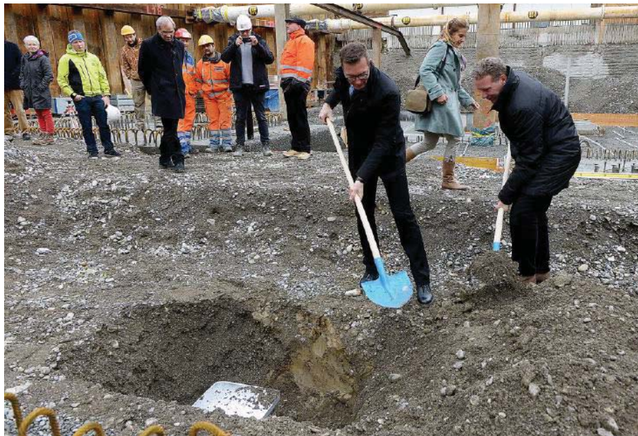
Mit vereinten Kräften: Stadtpräsident Raphael Lanz (mit Schaufel, links) und Stephan Gauer, Geschäftsleiter der Projektentwicklerin und Totalunternehmerin Alta Vista AG, an der gestrigen Grundsteinlegung für die Überbauung Vista Parc und das Bahnhofparking.
