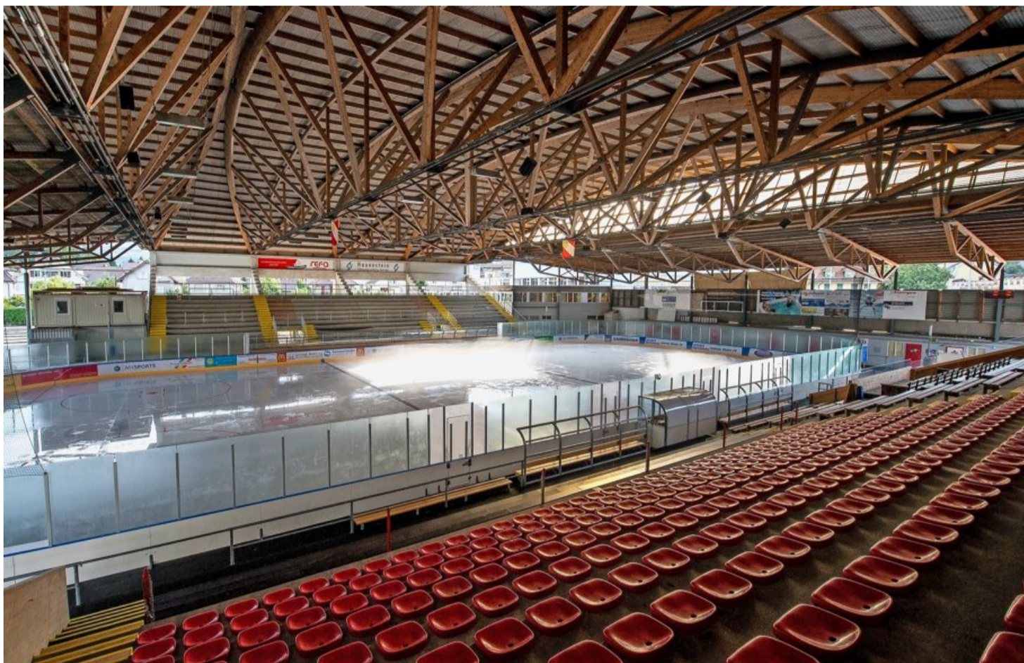
Die Kunsteisbahn Grabengut: Der Gemeinderat kann die Sanierung der Anlage weiterplanen.
