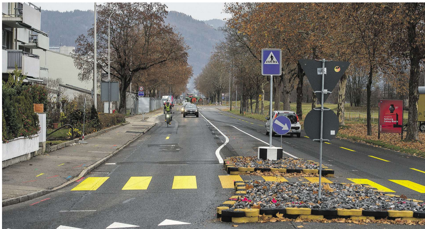
Die Allmendstrasse in Thun, vom Kreisel Waldeck aus fotografiert. Nach dem gestrigen Ja im Stadtrat wird die Stadt kommendes Jahr ab hier stadteinwärts einen 700 Meter langen Strassenabschnitt umfassend sanieren. Foto: Patric Spahni
