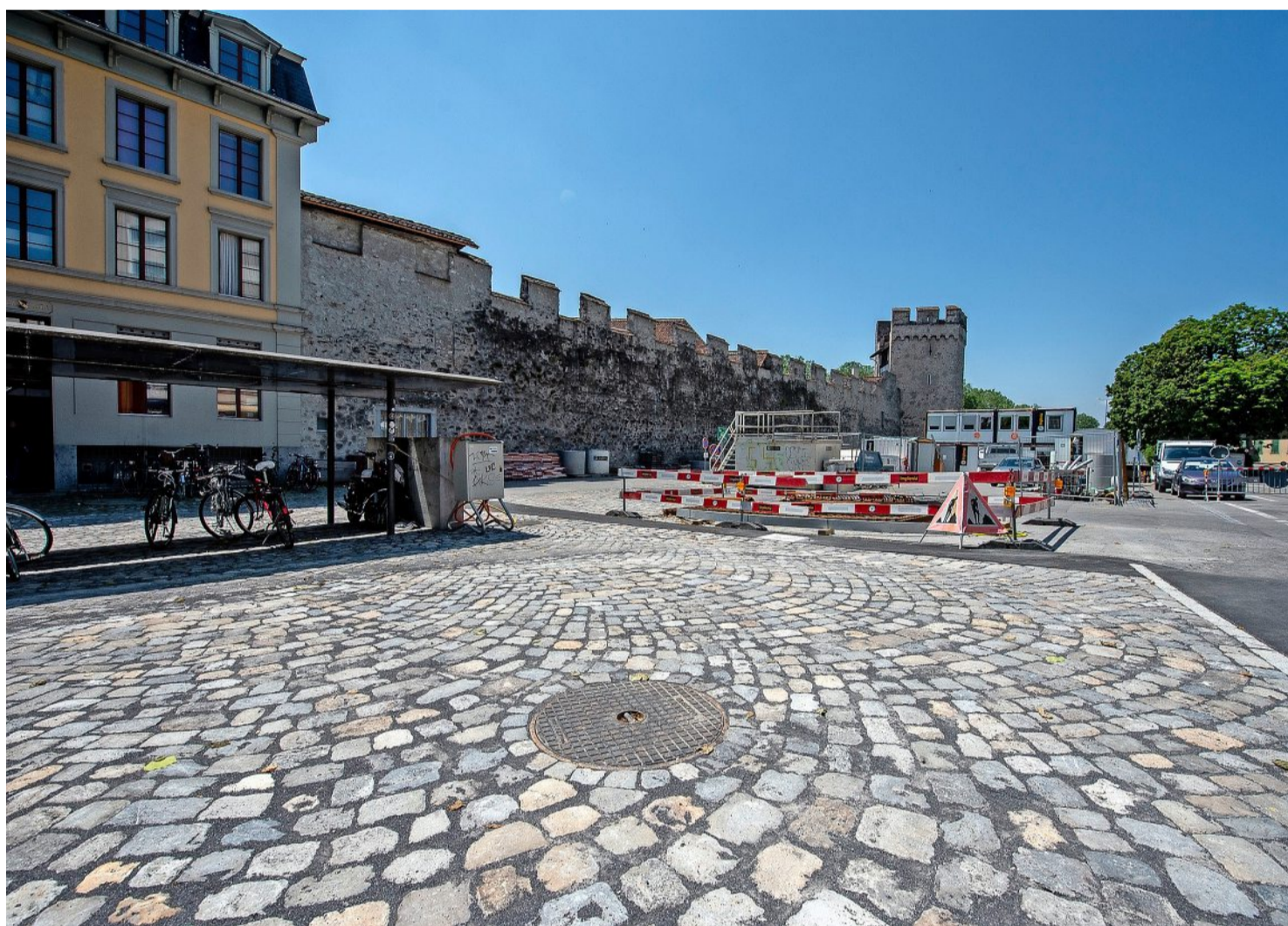
Der Thuner Viehmarktplatz direkt neben der historischen Stadtmauer, wie er derzeit aussieht – inklusive Baustelleninstallation. Foto: Patric Spahni
