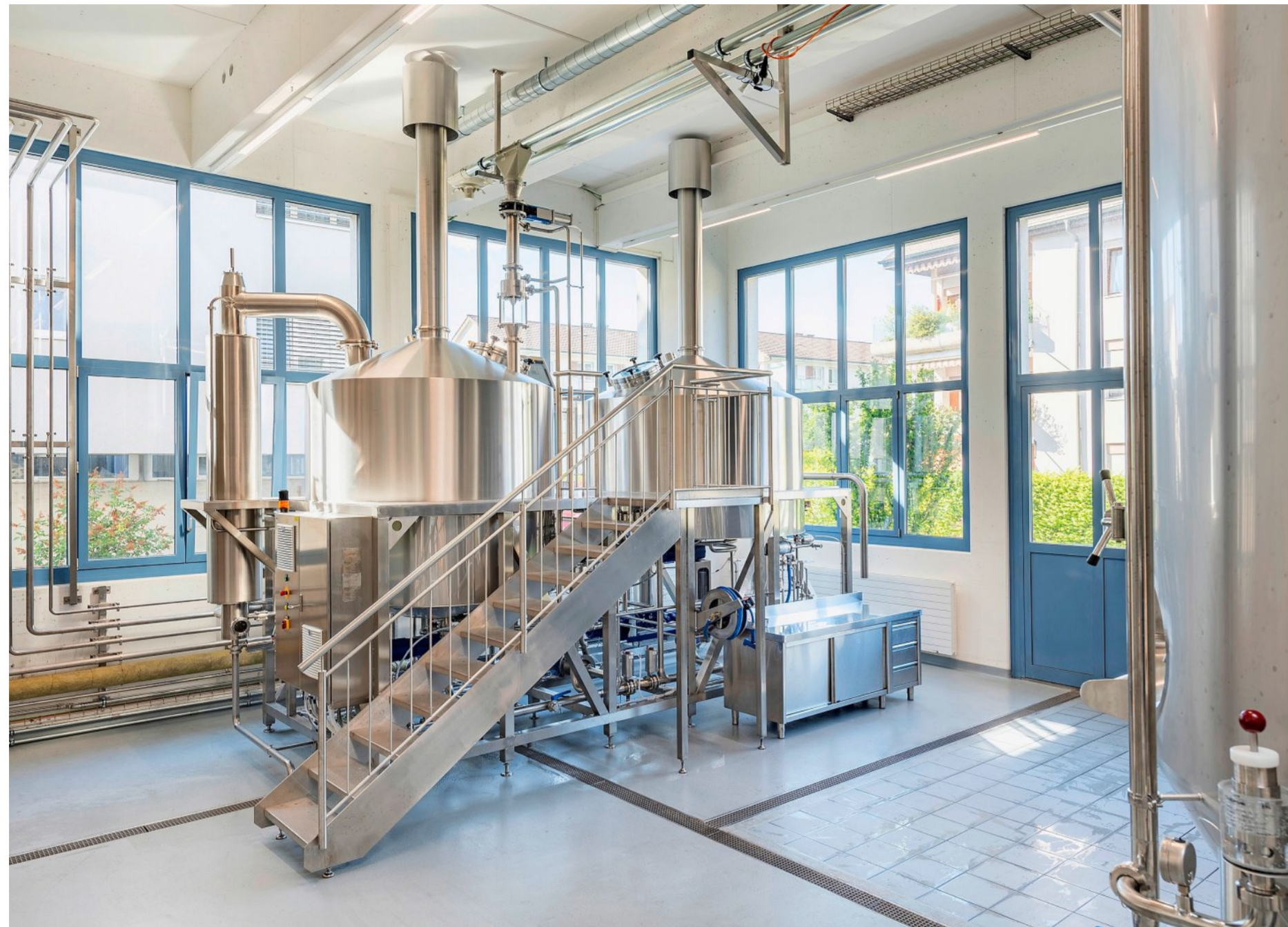
Das neue Sudhaus der Brauerei Thun AG in den Hallen der ehemaligen Grosswäscherei Reinhard. Fotos: PDI/David Schweizer
