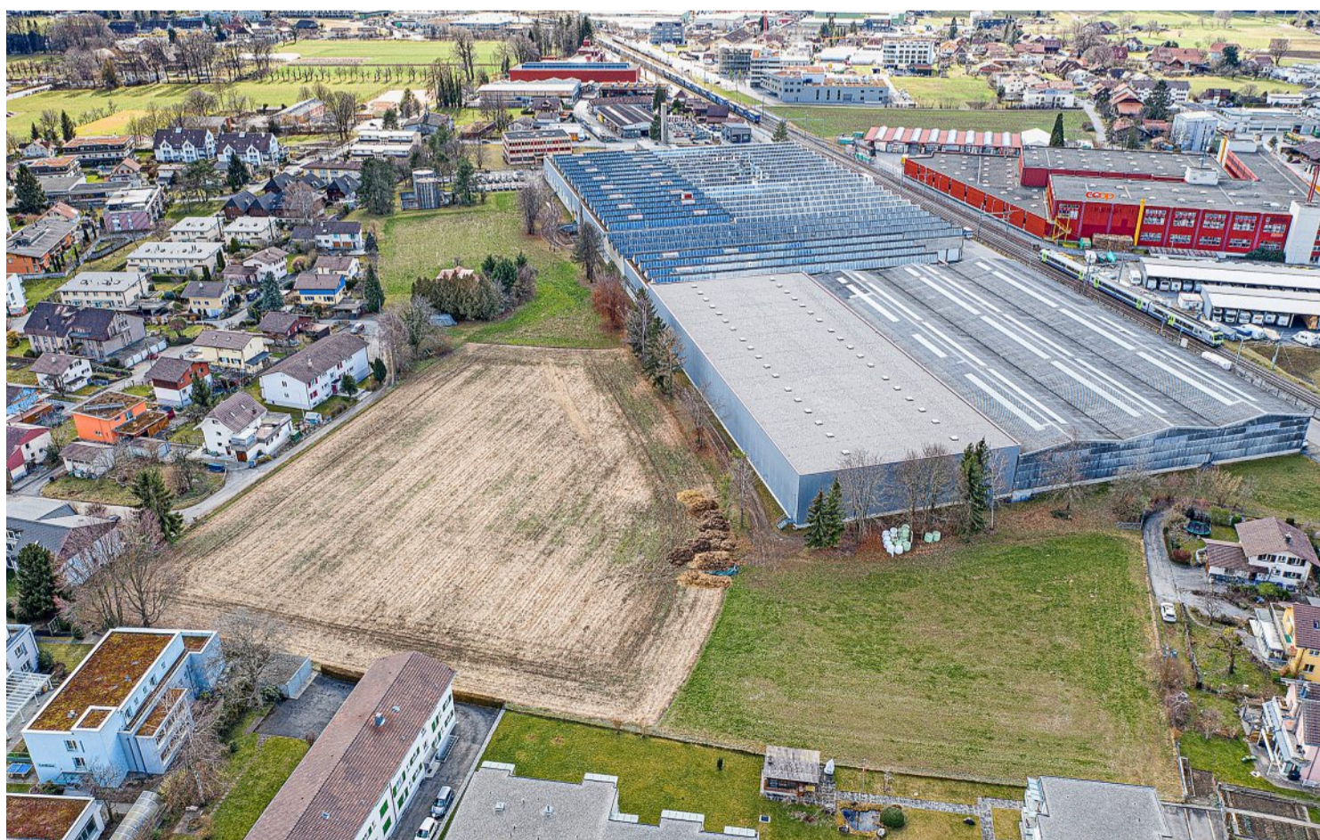
Die Überbauung soll auf der freien Fläche neben der Produktionshalle der Firma Hoffmann Neopac AG realisiert werden. Foto: Christoph Gerber
