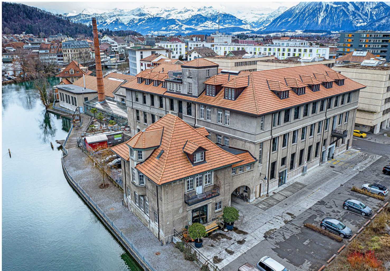
In diesem Gebäude im Thuner Selve-Areal befindet sich die Konzeptionhalle 6 (Eingang vorne rechts). Foto: Christoph Gerber
