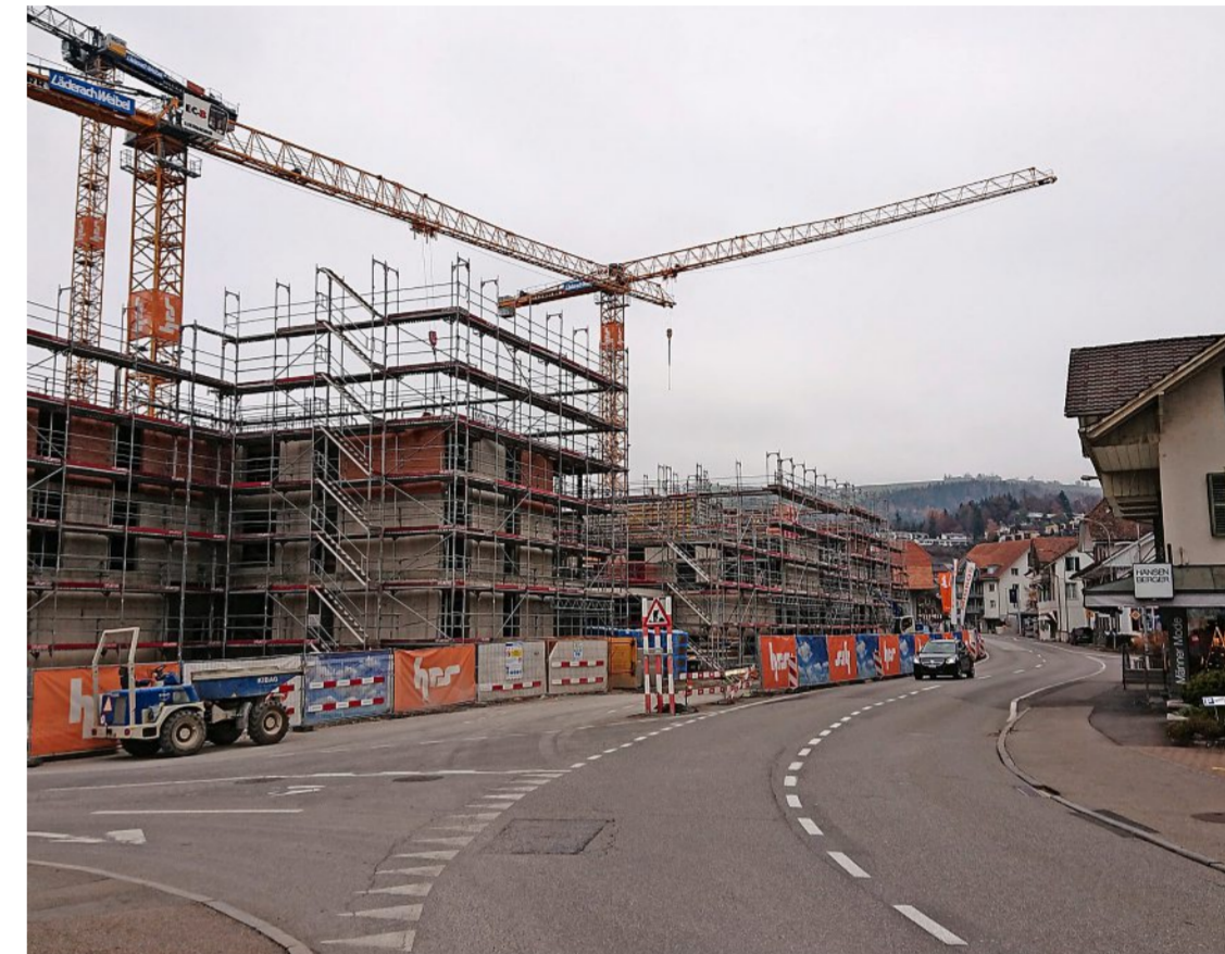
Die Einmündung von der Austrasse (l) in die Unterdorfstrasse wird zur Erschliessung der Läden und der Wohnungen auf dem Gschwend-Areal zu einem Kreislauf umgebaut. Foto: Marco Zysset
